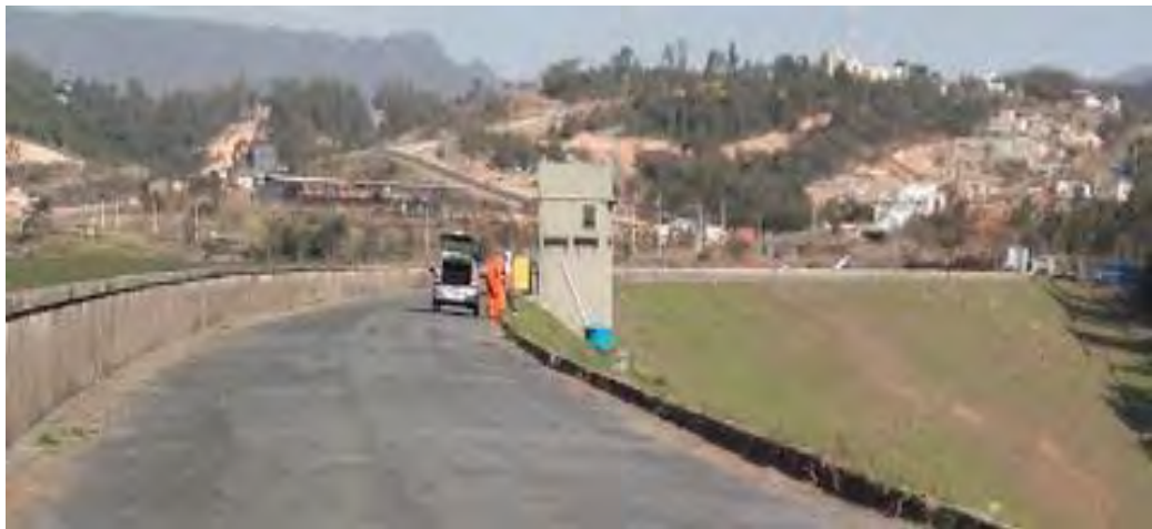
Foto 8: Mostra a situação em 2016, com o posto de Vigilância no centro do maciço da Barragem de Ibirité em destaque.
