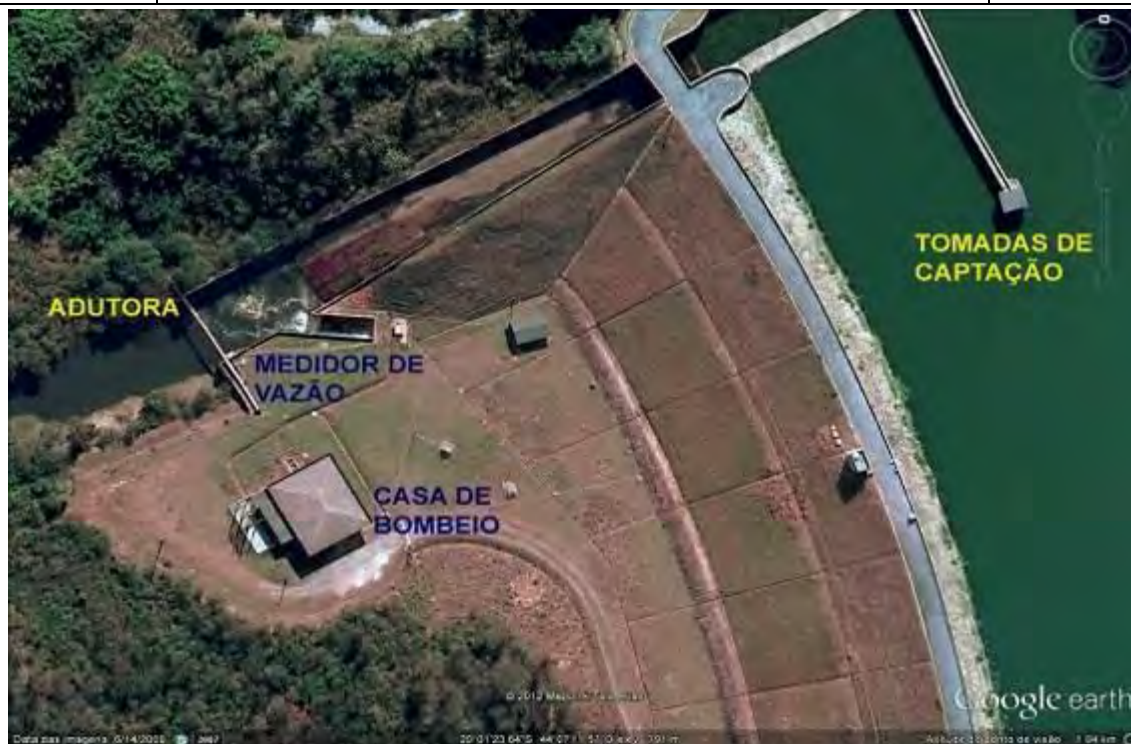
Figura 4: Ponto de Captação de Água, casa de Bombas e Medidor de Vazão na Barragem de Ibirité
