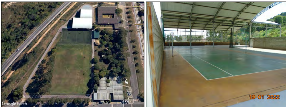
Figura 7.3-2 – Vista aérea da área dentro da REGAP (esquerda). Ginásio de esportes coberto (direita).
