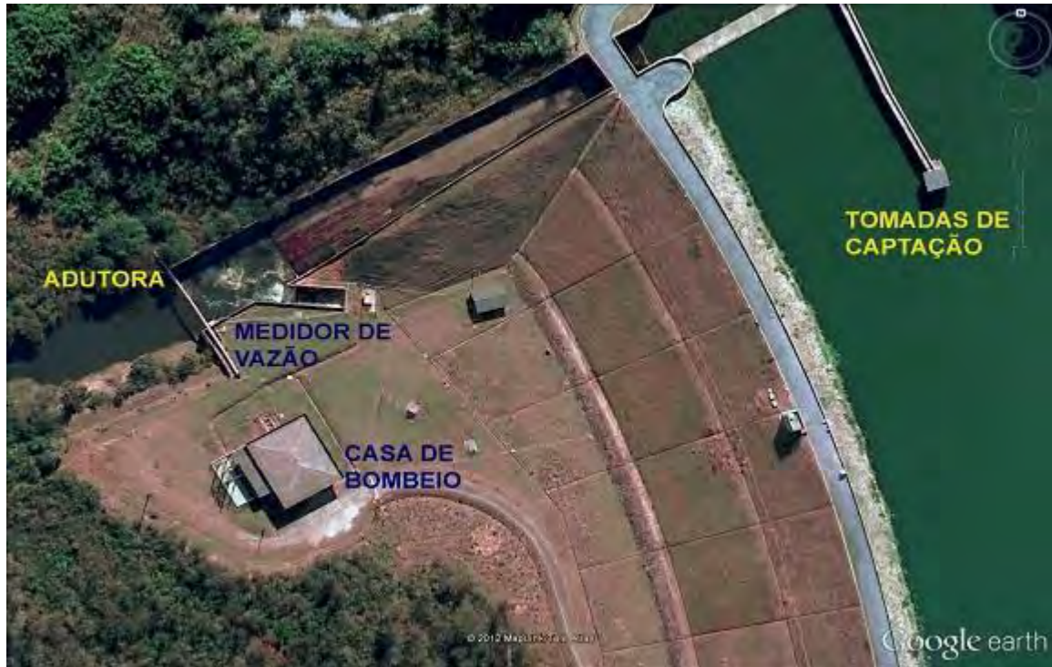
Figura 7 - Ponto de Captação de Água, casa de Bombas e Medidor de Vazão na Barragem de Ibirité. Fonte: Polar, 2013.
