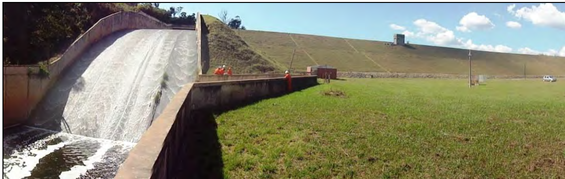
Foto 4.4: Vista panorâmica do vertedouro de superfície e talude de jusante.
