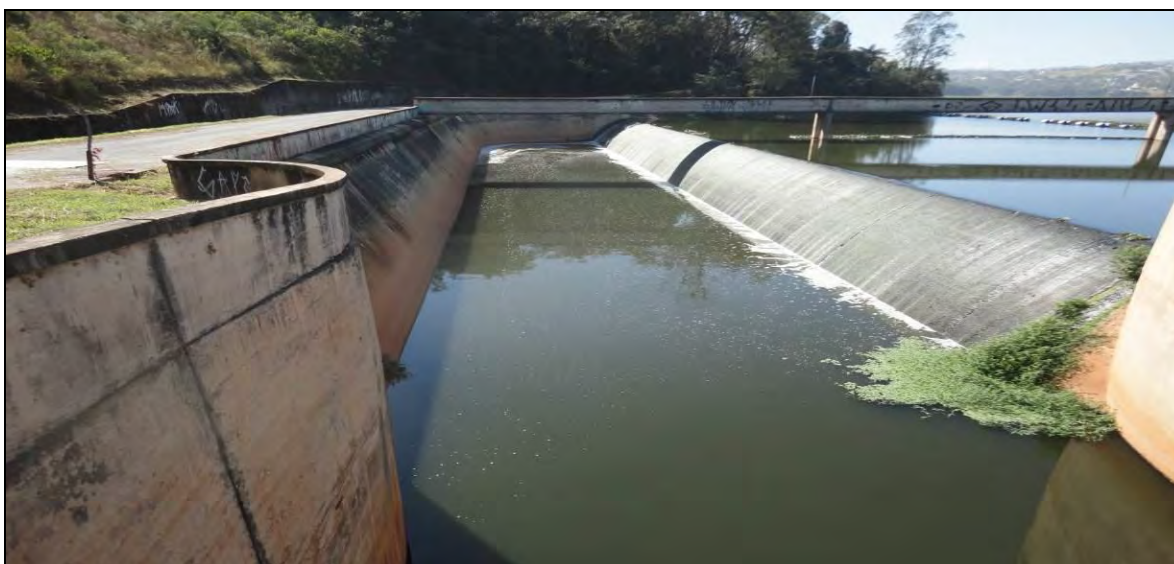
Foto 10 - Emboque do vertedouro de superfície (tipo side-channel).
