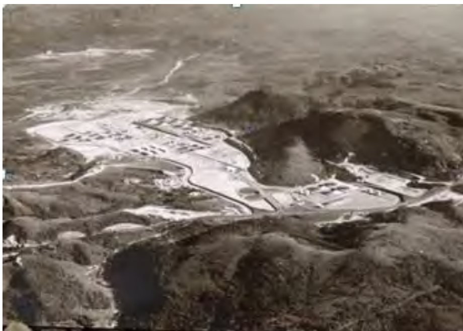
Foto 4: Foto histórica com uma visão aérea da região nos anos de 1968, com a REGAP em construção e ao fundo pode-se notar o início da movimentação de terra para construção da Barragem de Ibirité em um ambiente eminentemente rural.
