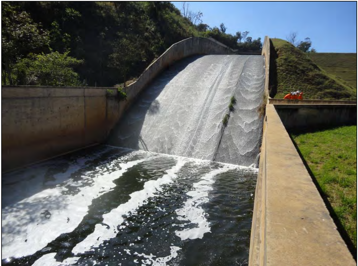
Foto 4.2: Emboque do vertedouro de superfície (tipo side-channel ).
