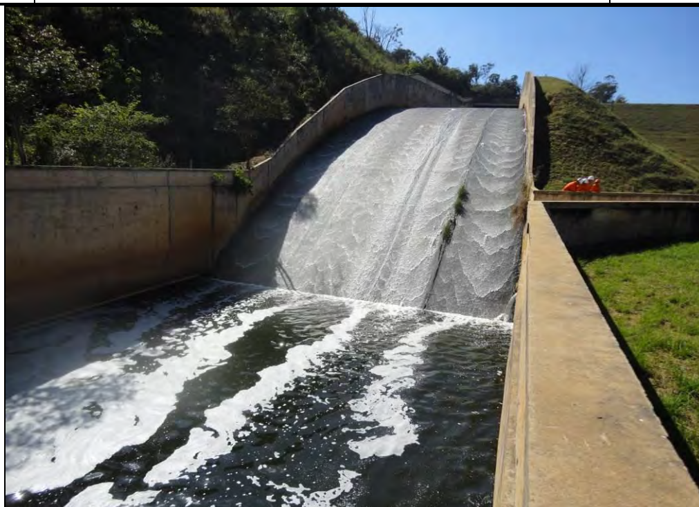
Foto 11 - Rápido do vertedouro de superfície.
