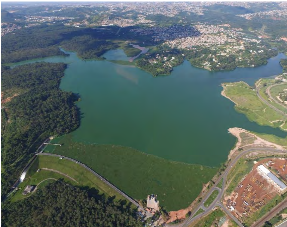
Figura 1: Imagem aérea da Barragem e da Lagoa de Ibirité com a presença de vegetação aquática de macrófitas flutuantes próxima ao maciço em 2021.
