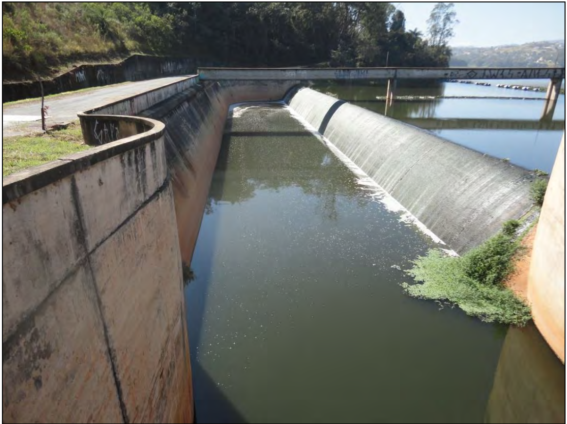
Foto 4.2: Emboque do vertedouro de superfície (tipo side-channel ).
