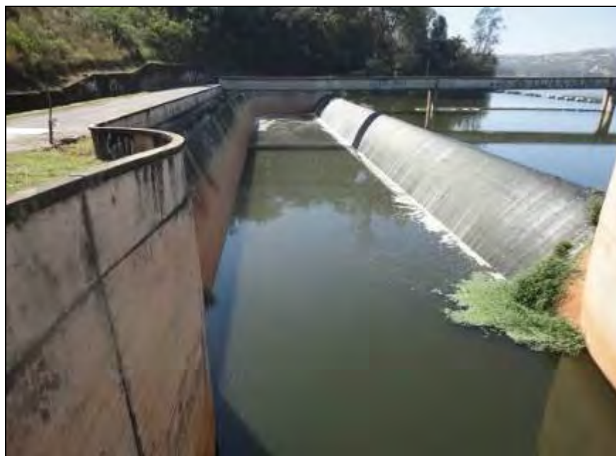
Foto 2: Emboque do vertedouro de superfície (tipo slide-channel).
