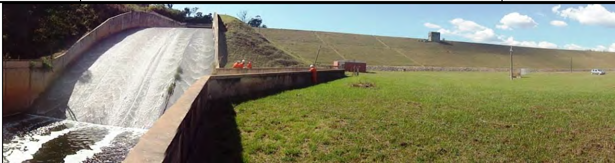
Foto 9 - Vista panorâmica do vertedouro de superfície e talude de jusante.
