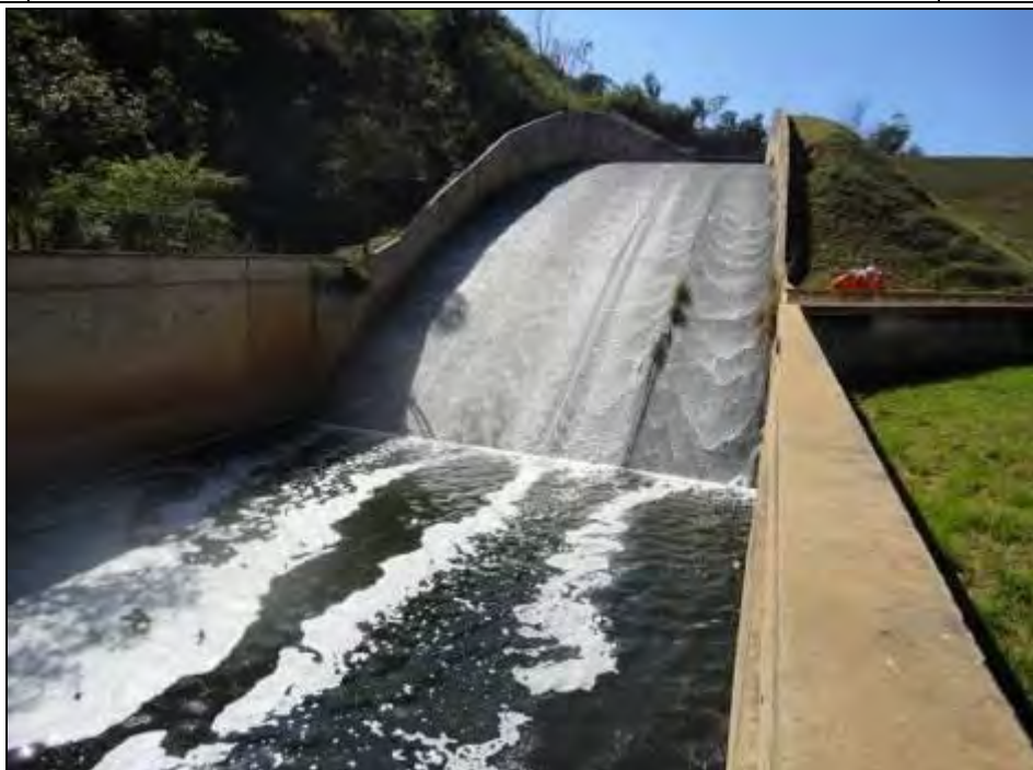
Foto 3: Rápido do vertedouro de superfície.
