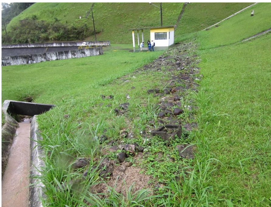
Fotografia 12 – Pé do talude de jusante protegido com colchão de pedras drenantes.
