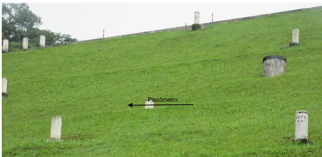
Fotografia 17 – Localização do Piezômetro SRPZ-FD no talude de jusante do barramento.
