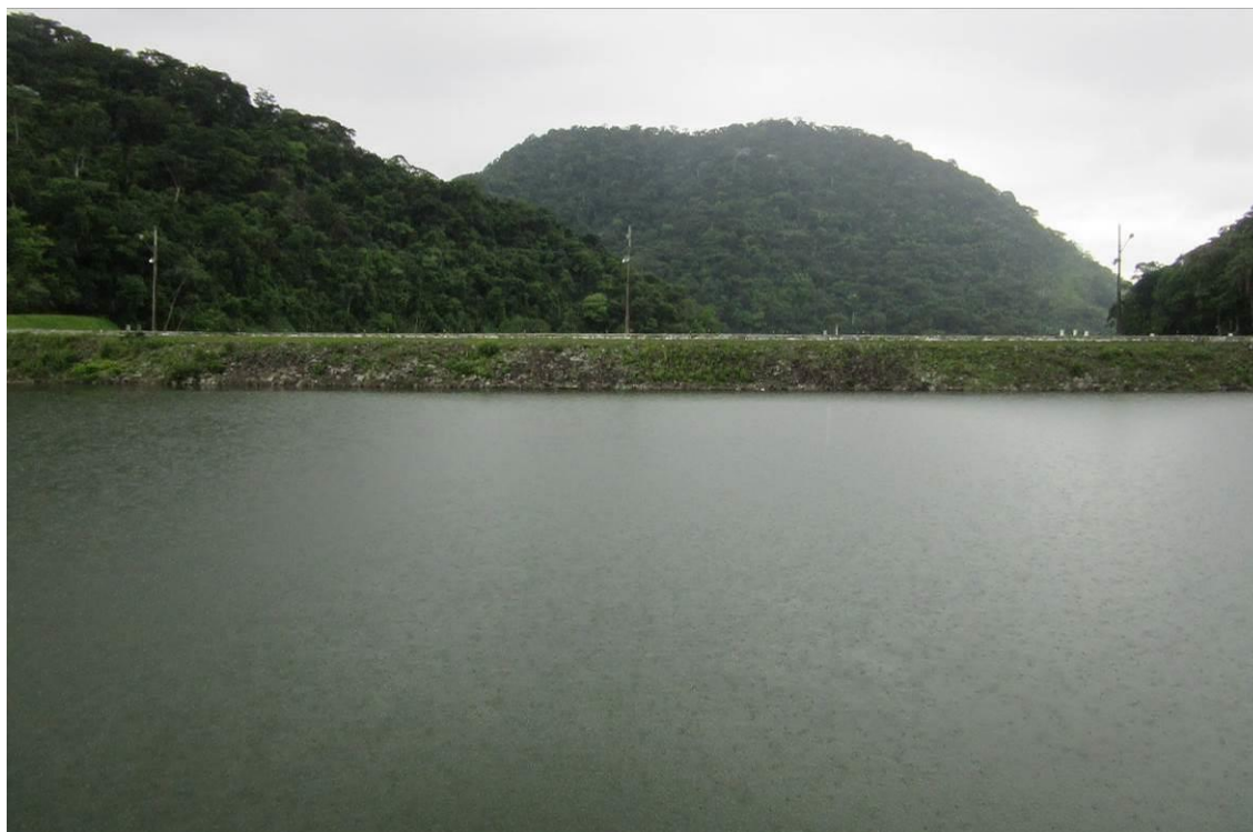
Fotografia 27 – Vista de parte do reservatório junto ao barramento.
