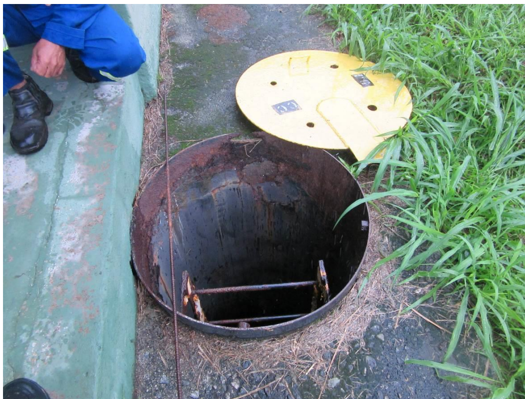
Fotografia 19 – Poço de inspeção que se encontra junto a ensecadeira, no pé do talude de jusante, ao lado da edificação existente no local.
