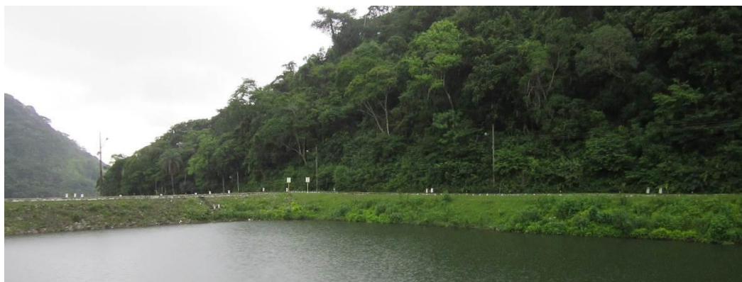
Fotografia 14 – Ombreira direita à montante do barramento.
