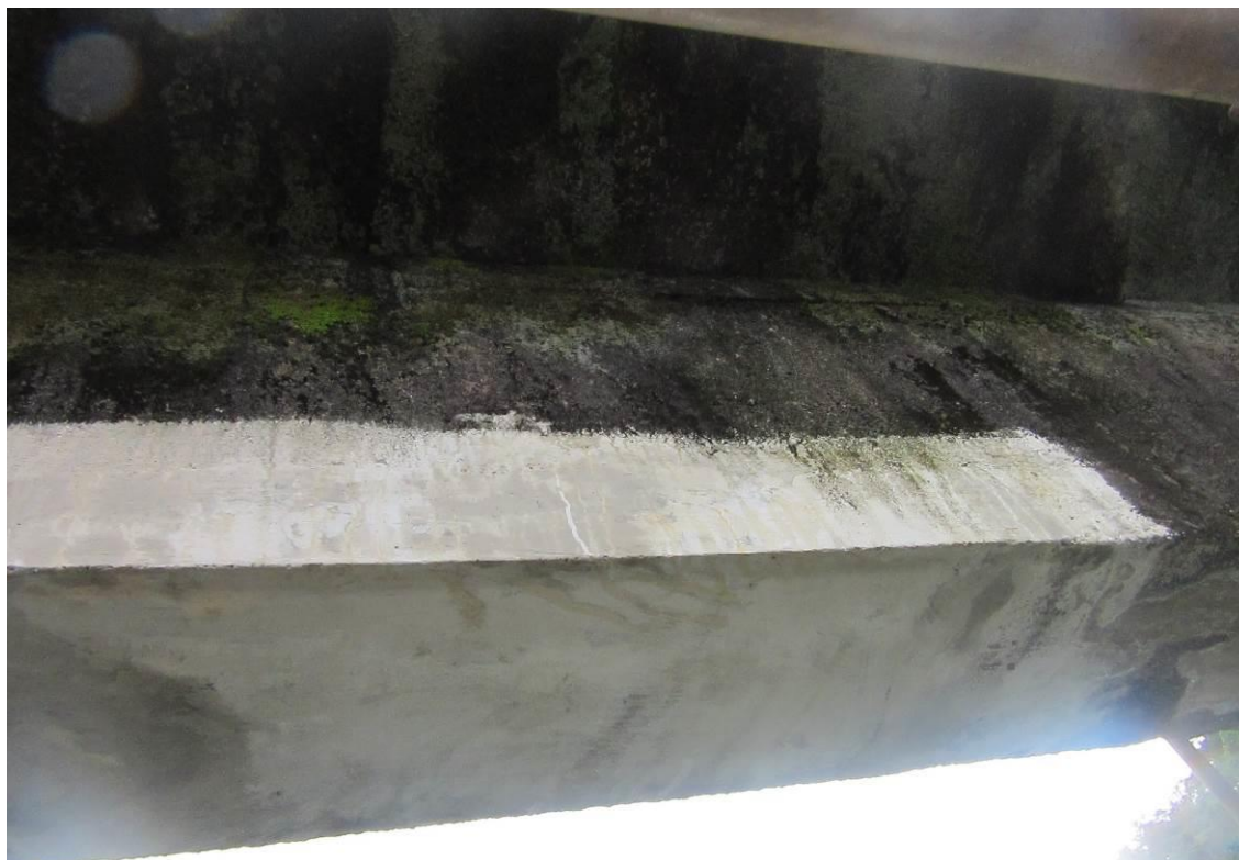
Fotografia 28 – Viga da passarela, próximo a torre, após o conserto.
