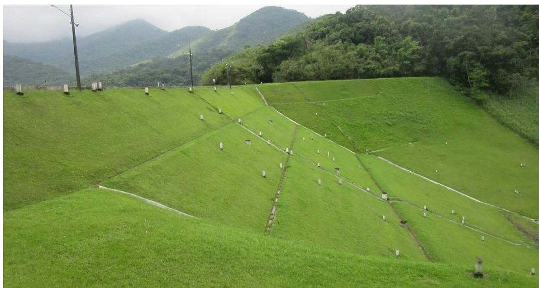
Fotografia 11 – Vista do talude de jusante.
