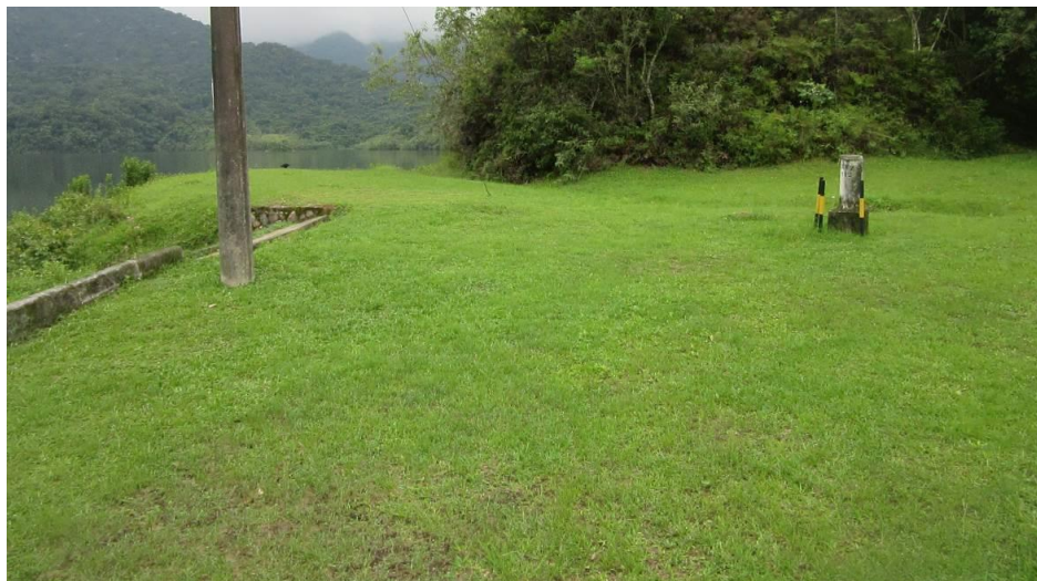
Fotografia 13 – Ombreira esquerda à montante do barramento.
