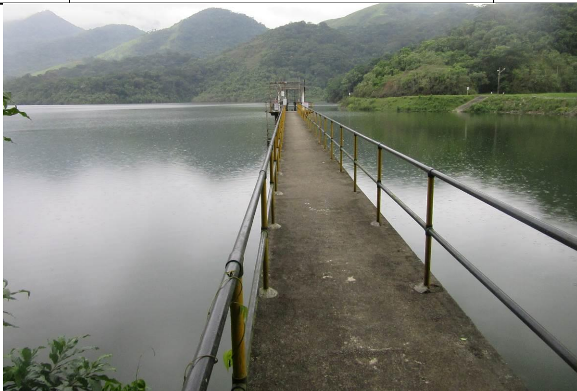
Fotografia 29 – Passarela e torre de tomada d'água.
