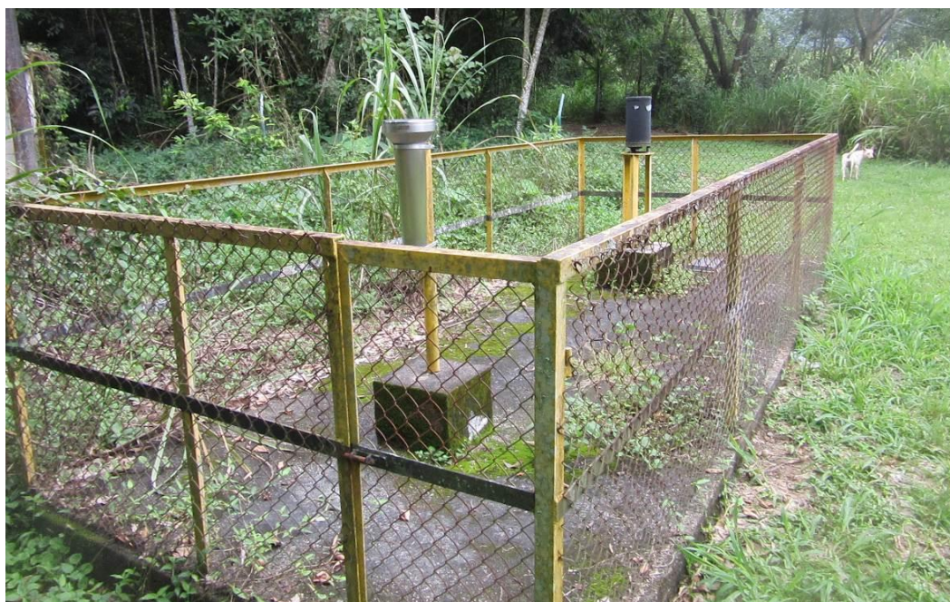
Fotografia 21 – Pluviômetro instalado junto ao escritório do sítio do barramento.
