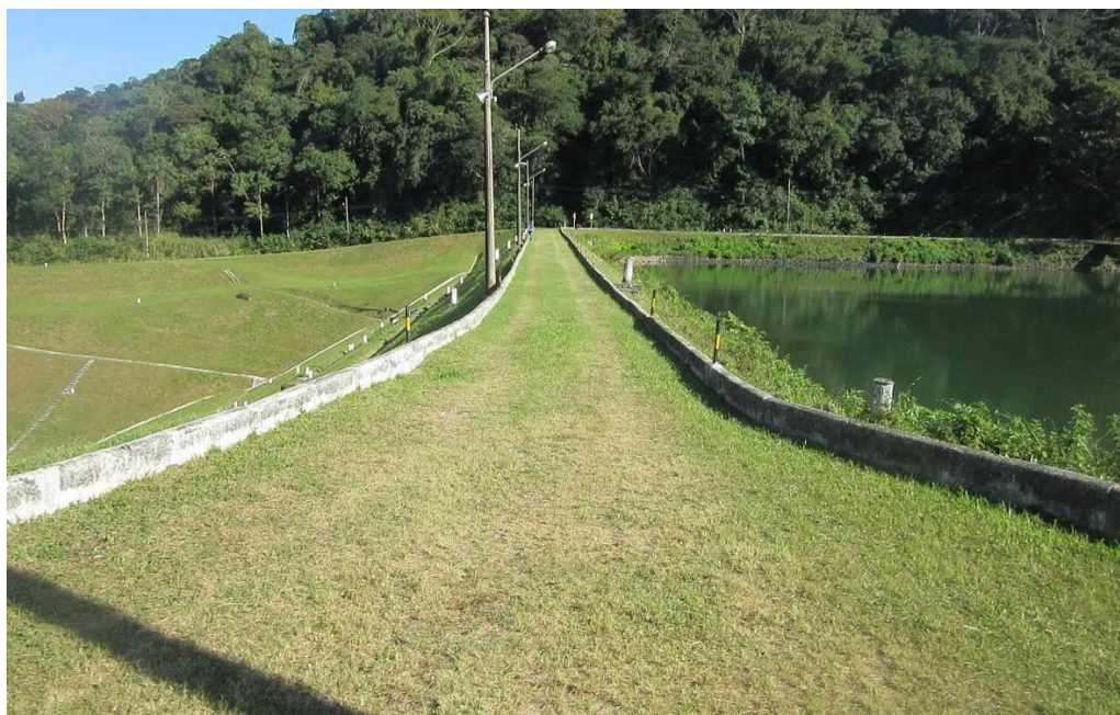
Fotografia 4 – Vista da crista da barragem.
